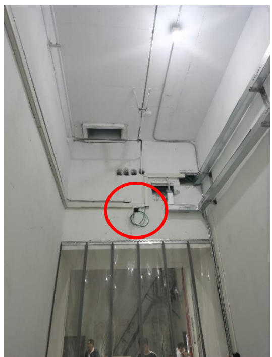
测试机房内监控探头
