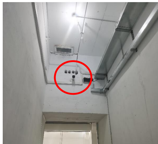
测试机房内监控探头
