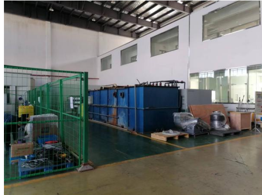
项目南侧（7#车间内其他工作区域）
