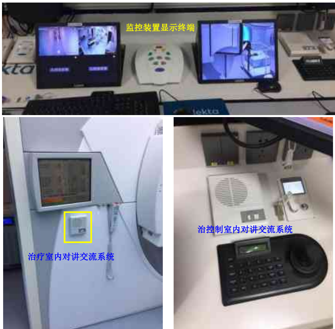
图 4-3 视频监控和监控对讲系统
