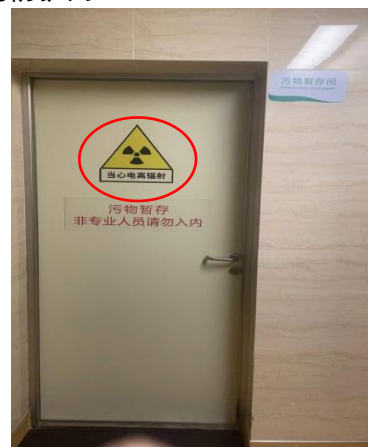
(b) 污物暂存间防护门
