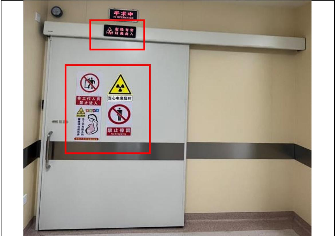
图3-2 (1) DSA机房南侧防护门（病人入口）闭门状态
