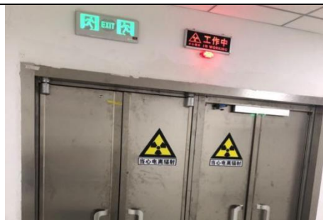
(i) 核医学科入口防护门
