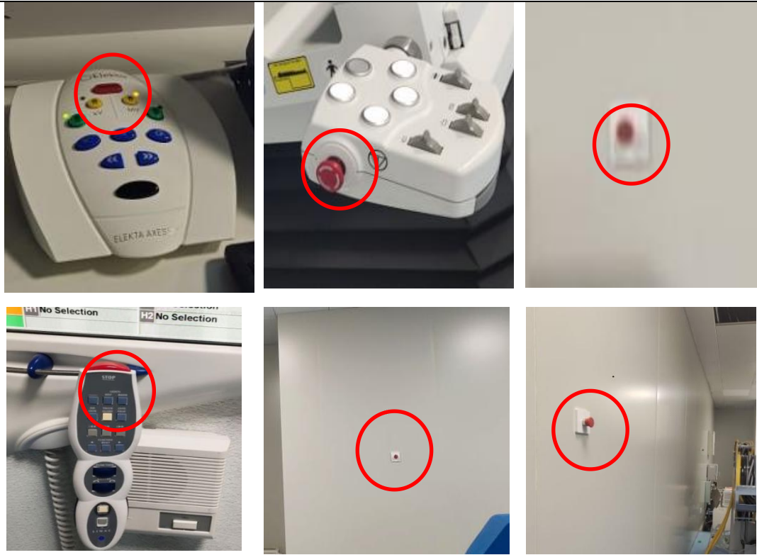
(a) 医用直线加速器1号机房
