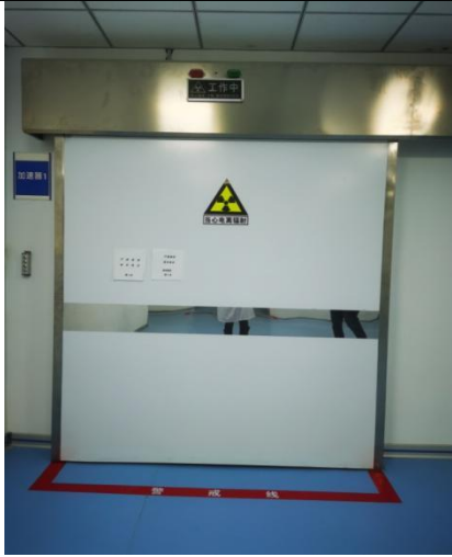
(a) 医用直线加速器1号机房防护门
