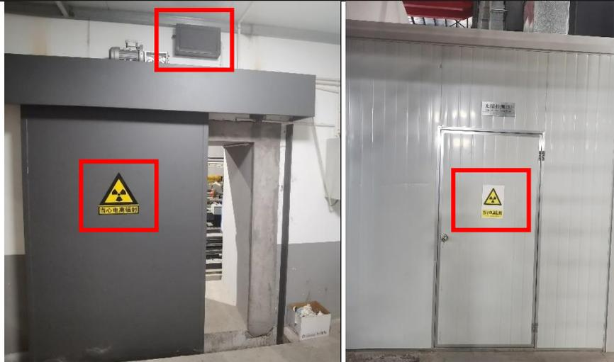
图3-2-3 本项目探伤室3工作状态指示灯和电离辐射警告标志
