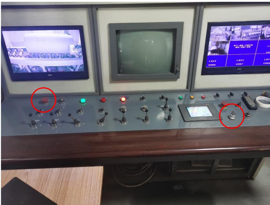
图3-3-1 本项目探伤室1操作台设置急停按钮及钥匙开关
