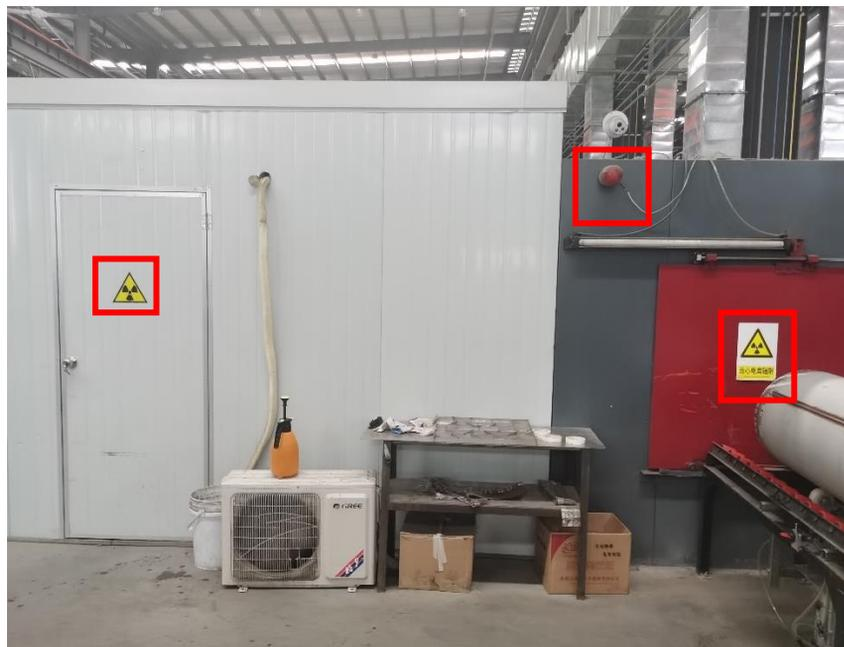
图3-2-2 本项目探伤室2工作状态指示灯和电离辐射警告标志
