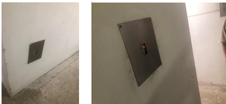
图3-7 本项目红外光电防人误入装置
