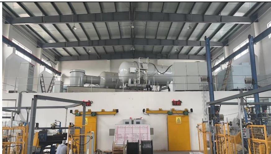
图3-2 本项目2座工业电子加速器机房现场正面图
