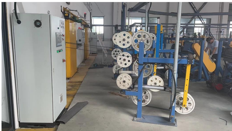
图3-3 本项目2座工业电子加速器机房外监督区现场图
