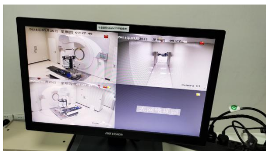
(b) 控制室内监控显示终端
