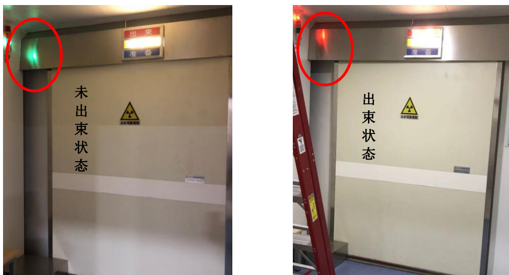
图 4-2 工作状态指示灯和电离辐射标志
