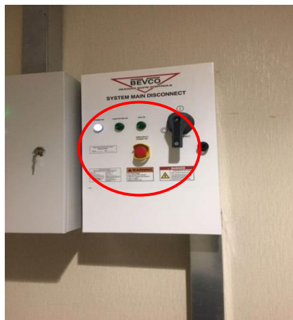
核医学楼 1 楼 PET/CT 设备
