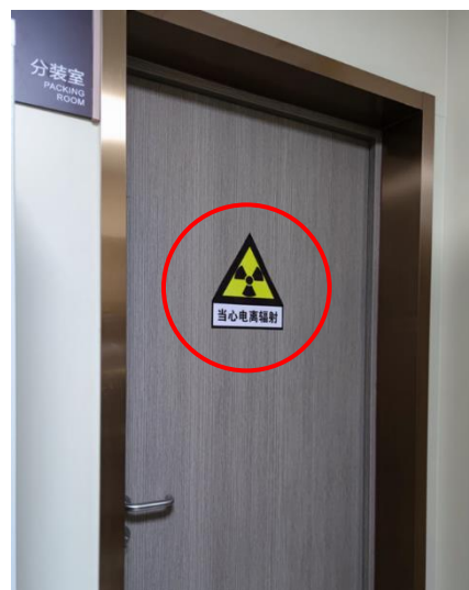
分装室防护门
