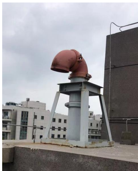
核医学楼楼顶通风口
