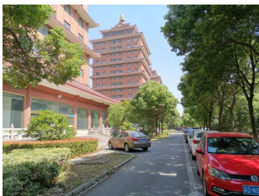
图 8-1 华西村 5 号塔东侧
