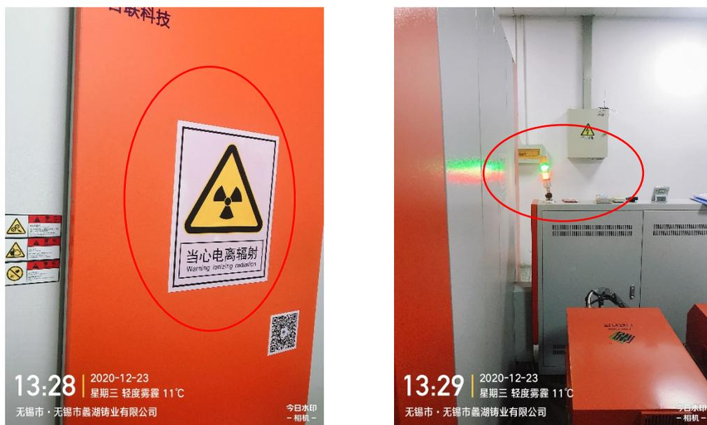
图 4-2 X 射线实时成像检测装置电离辐射警告标志及工作状态指示灯
