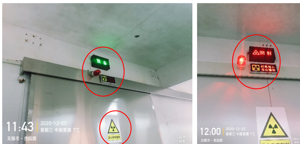
图 4-2 X 射线数字成像系统电离辐射警告标志及工作状态指示灯
