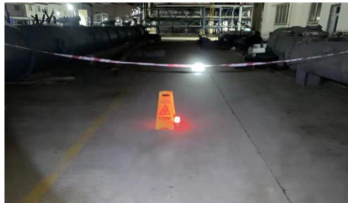
图 4-2 声光报警装置和警戒线
