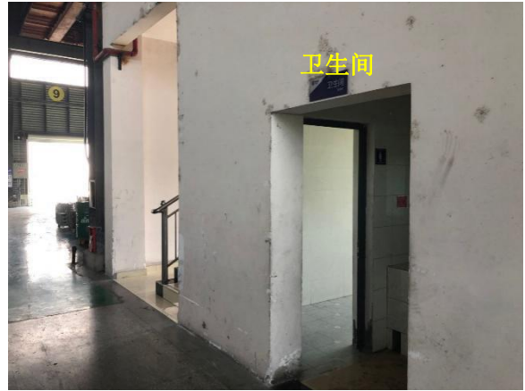
图 8-6 1#X 射线成像检测系统北侧
