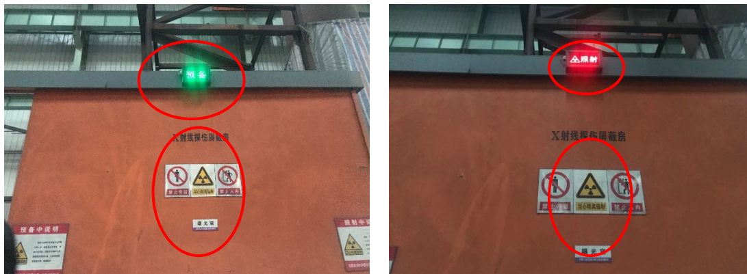
图 4-2 电离辐射警告标志及工作指示灯
