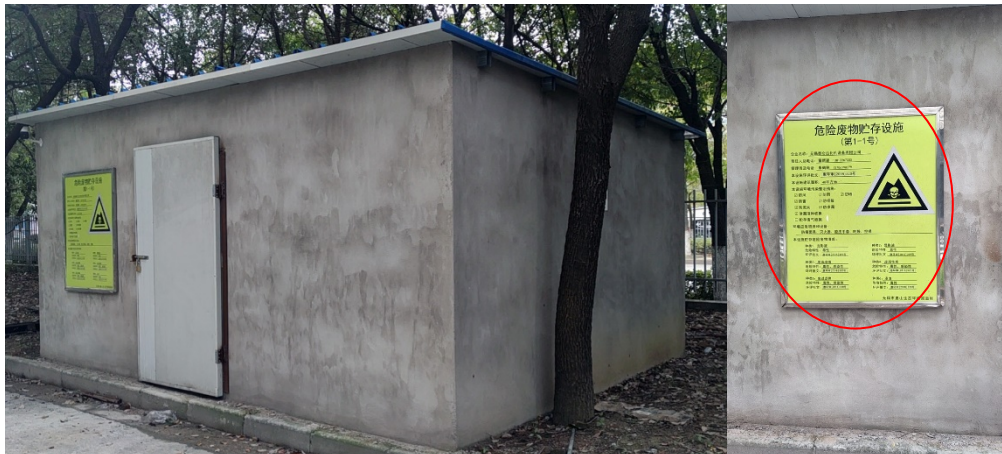
图 4-7 废物库及危险物警告标识
