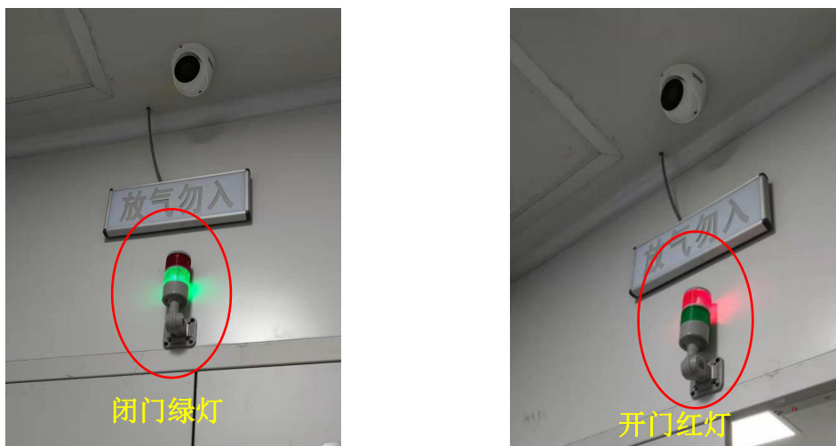
图4-6 工作状态指示灯和门灯联锁装置
