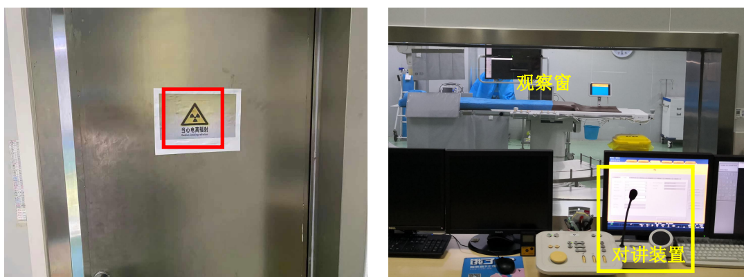
图 4-3 DSA 检查室控制室门
