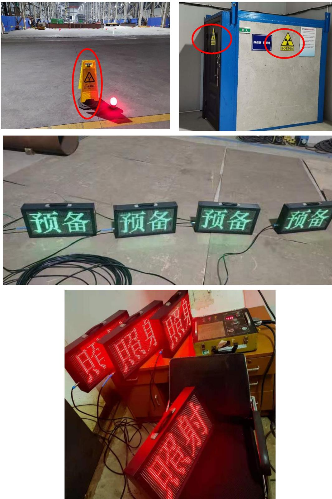
图 4-2 电离辐射警示标志及警示信号指示装置
