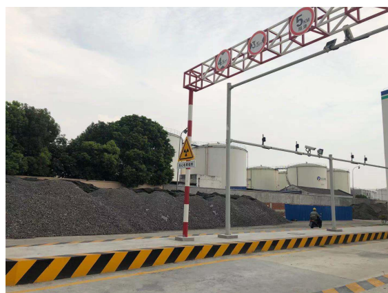
扫描大厅东侧长江国际码头 (化工品储存罐区)
