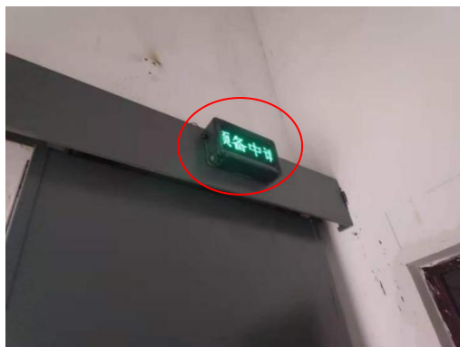
图 4-2 固定式 X 射线探伤房防护门上工作状态指示灯
