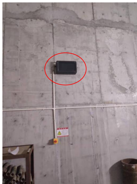
图 4-4 曝光室内工作指示灯
