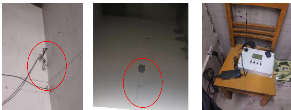
图 4-10 放射源源库监控与报警装置
