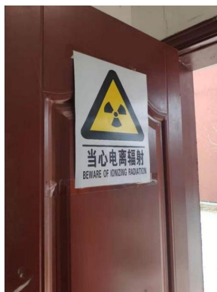
图 4-6 控制室西门上电离辐射警告标志
