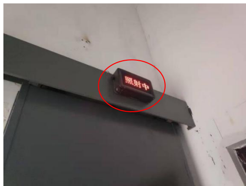
图 4-2 固定式 X 射线探伤房防护门上工作状态指示灯
