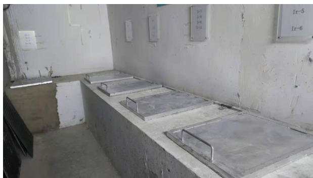
图 4-13 源坑上方铅板防护
