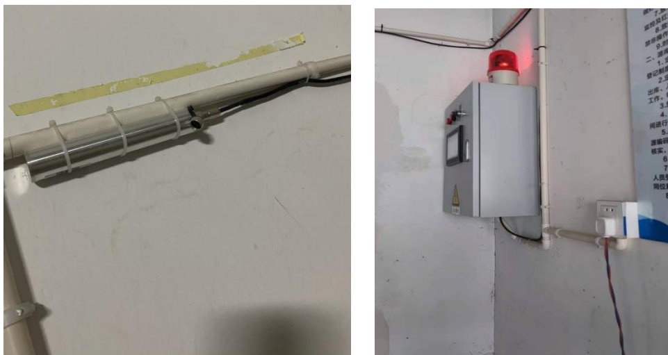
图 4-8 固定式计量探头和声光报警器
