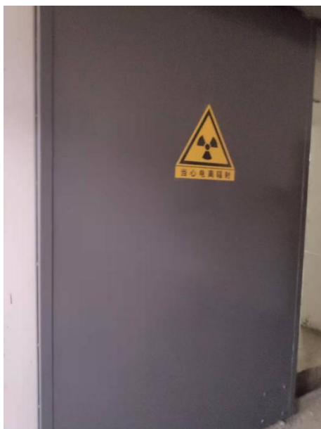
图 4-3 固定式 X 射线探伤房防护门 电离辐射警告标志
