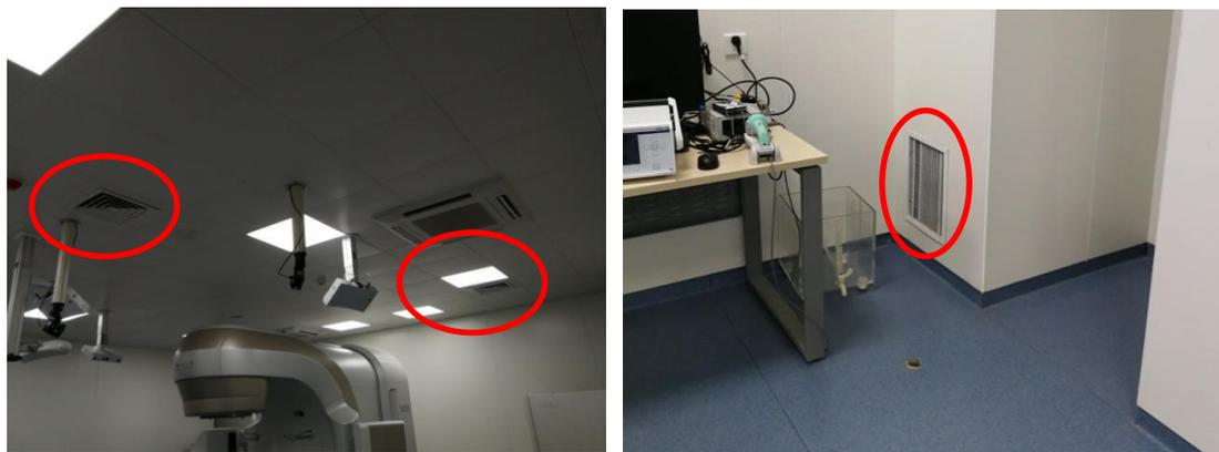
图 4-15 医用直线加速器机房内的排风口
