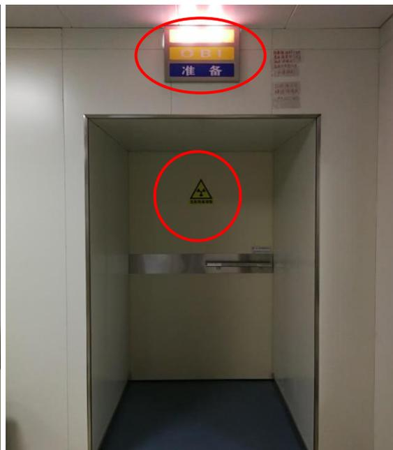
图 4-5 加速器机房防护门
