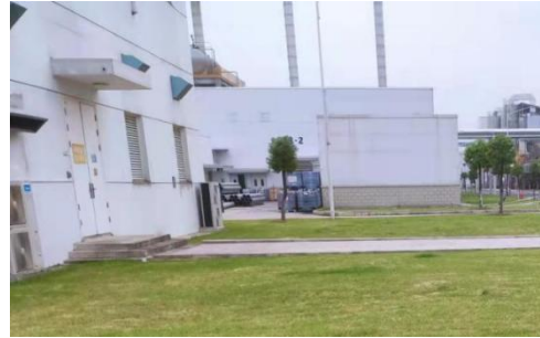
中水值班室和中水化验室
