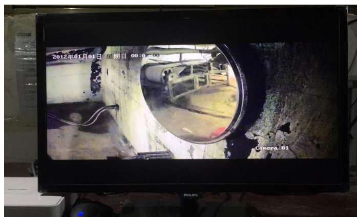
图 4-18 实时摄影监视装置照片
