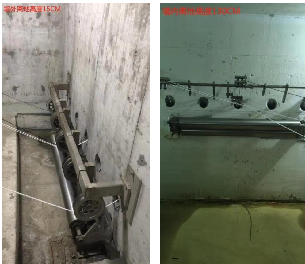
图 4-27 热缩带穿墙照片
