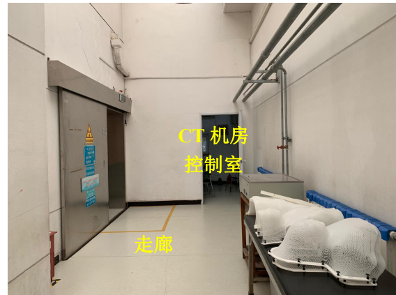
图 8-4 1 号加速器机房改建址北侧
