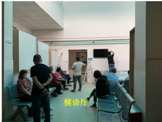
图 8-3 1 号加速器机房改建址西侧
