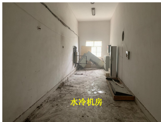
图 8-2 1 号加速器机房改建址南侧
