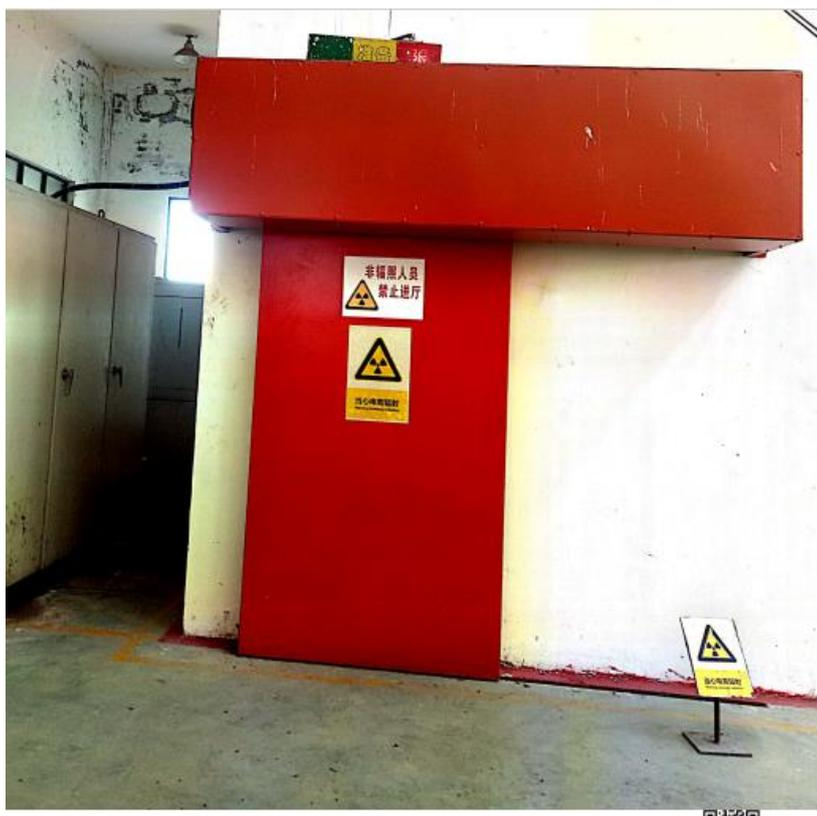
图 4-4 工业辐照加速器工作状态指示灯和电离辐射警告标志
