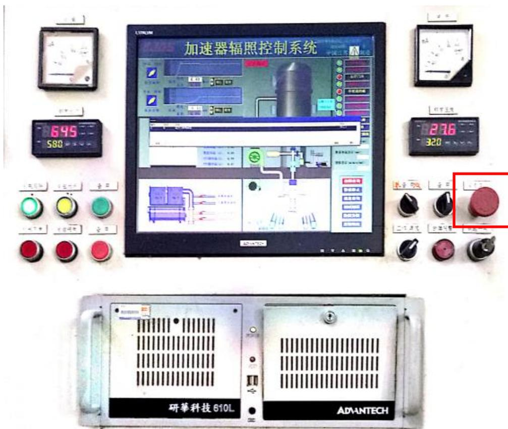
图 4-3 工业辐照加速器控制台束下控制系统及界面（方框处为急停按钮）
