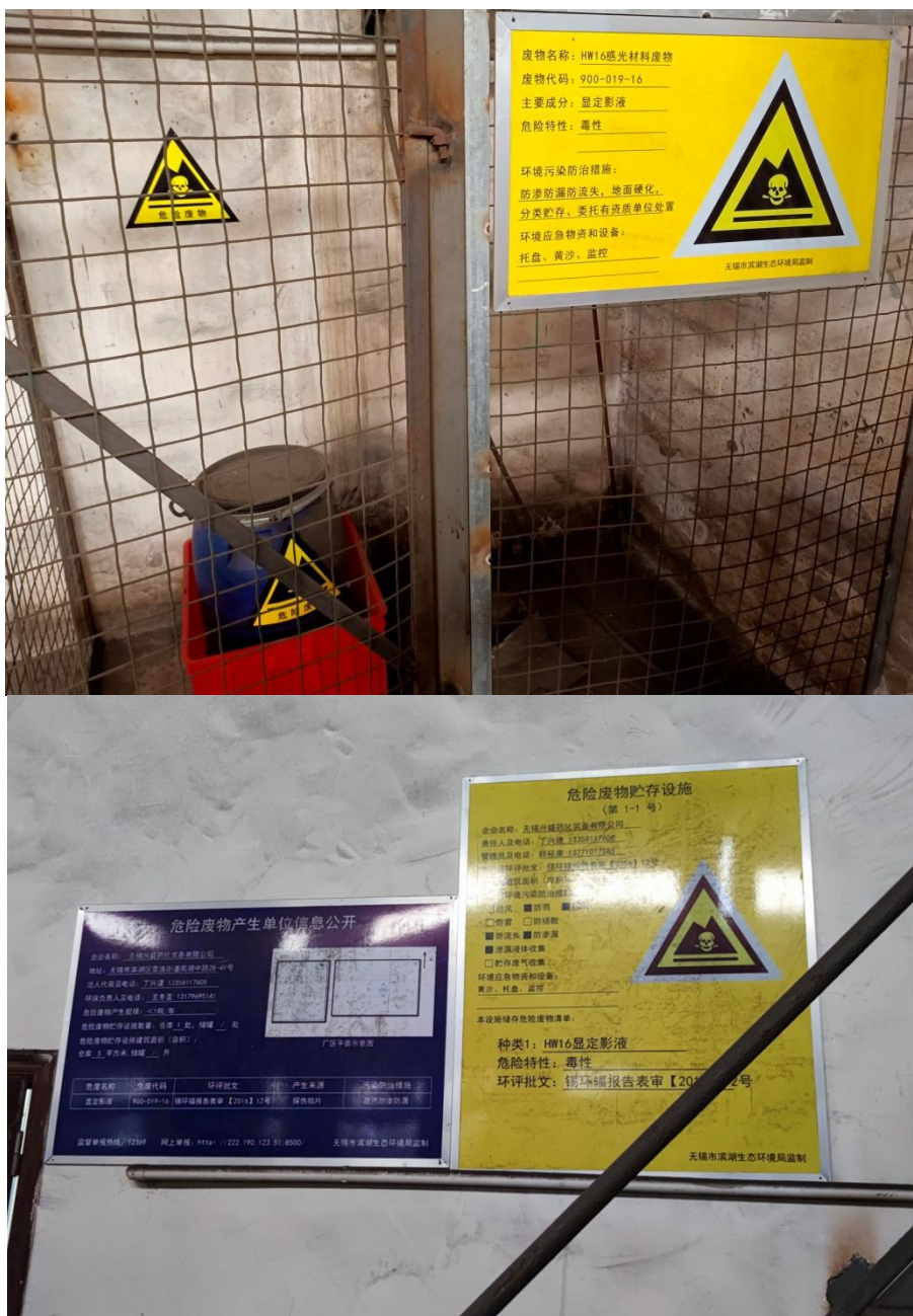
图 4-6 危废暂存场所、容器及危险废物警示标识
