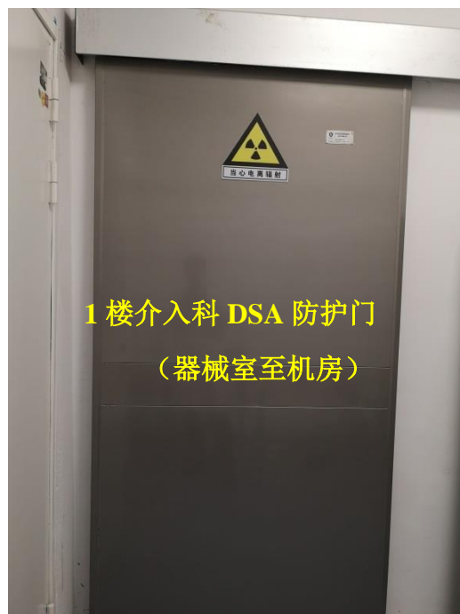
图 4-3 DSA 机房防护门
